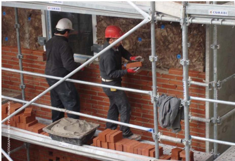
*Ce type de façade a des avantages techniques indéniables : Isolation et inertie thermique sont élevées, les ponts thermiques sont supprimés. Par ailleurs, la brique naturelle massive offre une grande durabilité, elle se patine avec le temps quand les autres matériaux se dégradent. Elle est fabriquée par simple cuisson d'un matériau naturel et abondant.*
