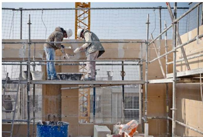
La pierre calcaire d'élévation est extraite des carrières de Noyant (page précédente), puis découpée selon un calepinage régulier. Les linteaux sont clavetés de manière traditionnelle sur proposition d'économie de l'entreprise. La tolérance du joint de clavetage est réglée à la tronçonneuse. Le jointolement est réalisé au plâtre avant ravalement et rejointolement au mortier de chaux.
